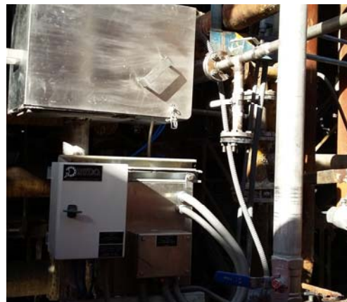
Figura 2. MV-21-N Montaje mediante bypass
